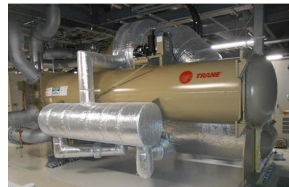
ノンフロン冷媒採用ターボ冷凍機
